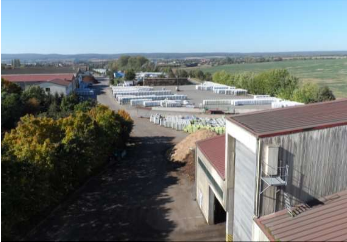
Abb. 86: Erdenwerk und Palettenstellflächen
