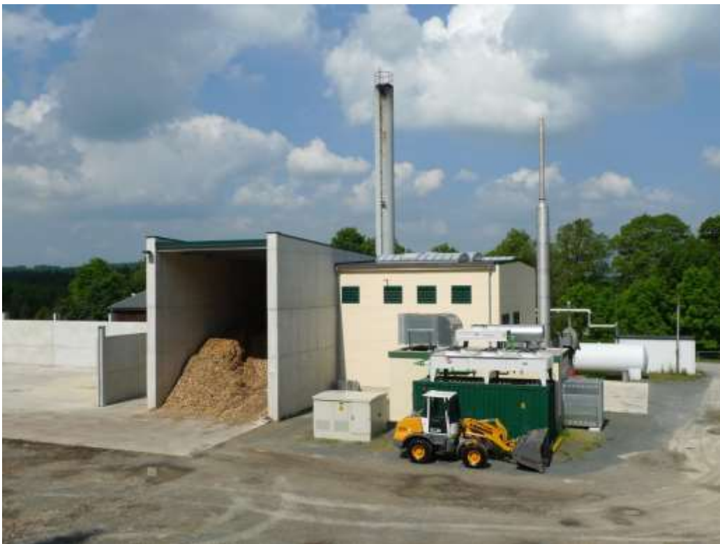
Abb. 78: Heizwerk Tanna - Außenansicht
