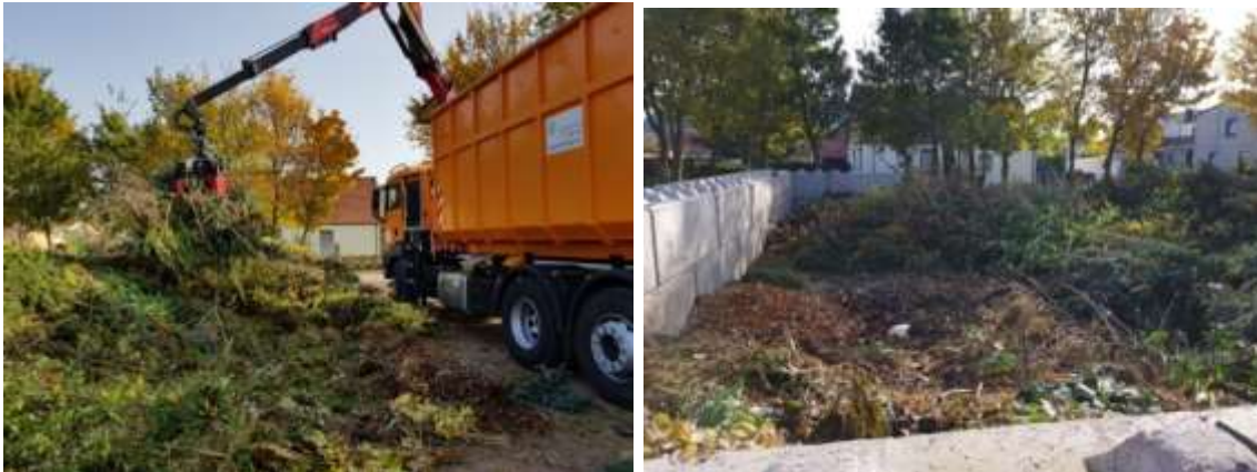
Abb. 76: Grünabfallannahme auf befestigter Fläche und Beräumung mit Containerfahrzeug
