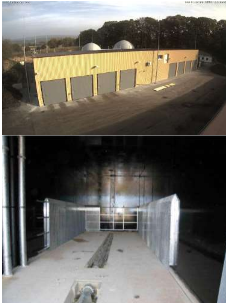
Abb. 62: Vergärungsanlage Lohfelden (LK Kassel) und Innenansicht eines Boxenfermenters
