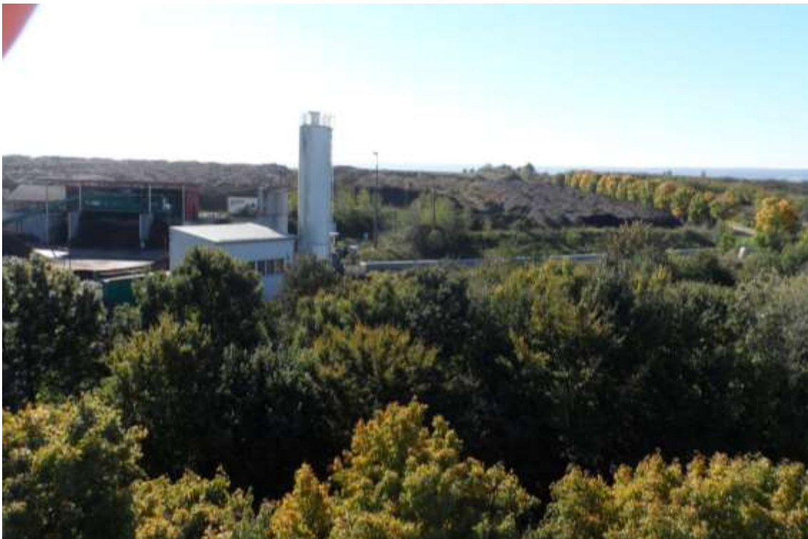
Abb. 85: Lagerflächen für Substratausgangsstoffe, Sternsieberanlage und Mischanlage
