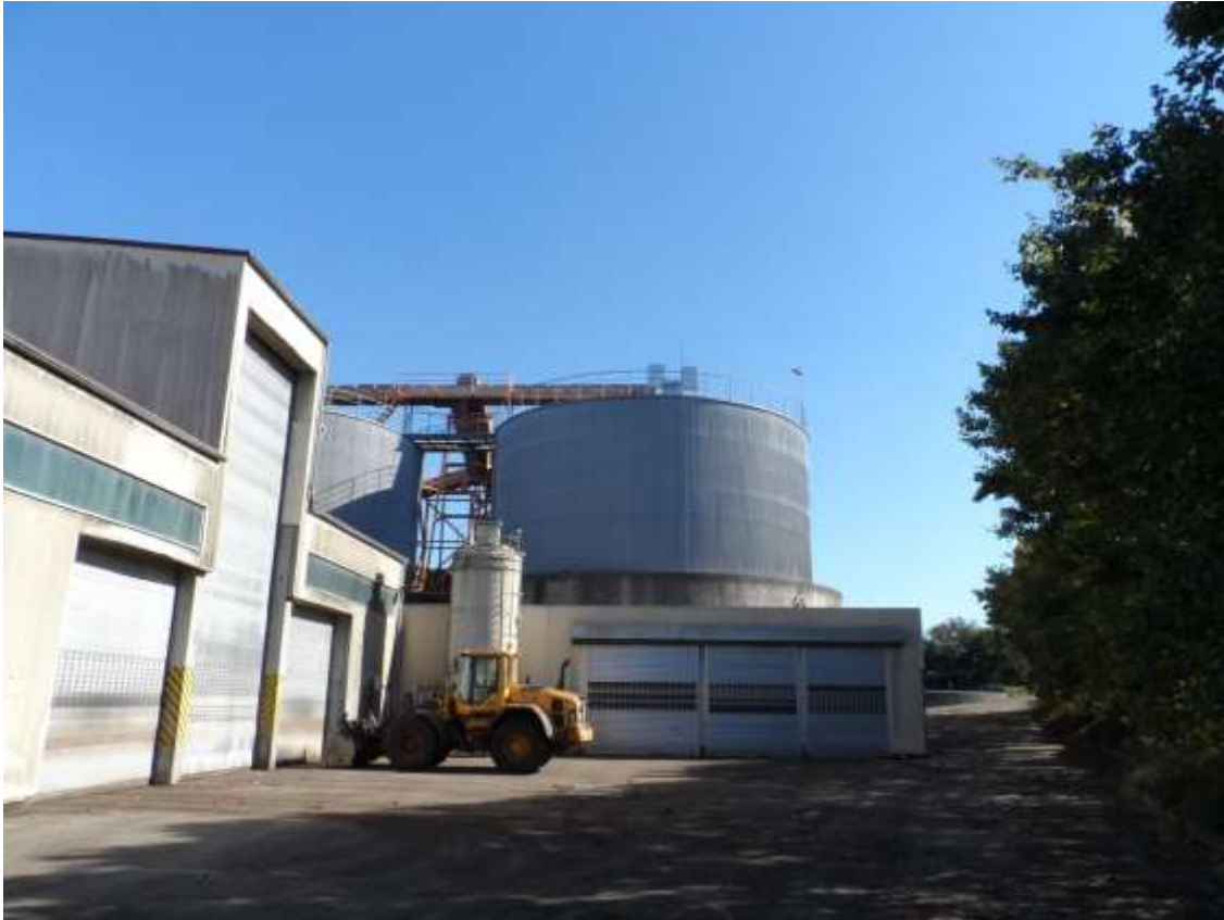
Abb. 84: Kompostwerk mit Aufbereitungshalle und Rottetürmen
