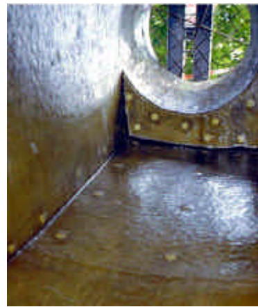
Abbildung 55: Auskleidung mit GF-UP-Platten
