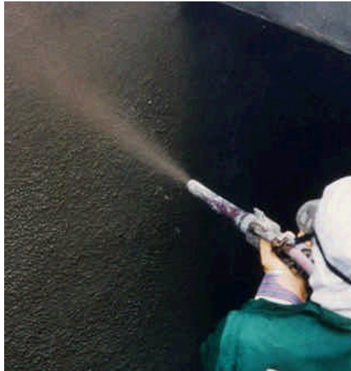
Abbildung 48: Spritzmörtelauftrag im Nassspritzverfahren
