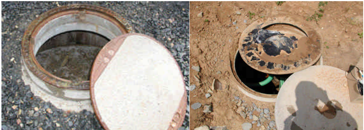
Abbildung 35: Charakteristische Deckel von Kleinkläranlagen
