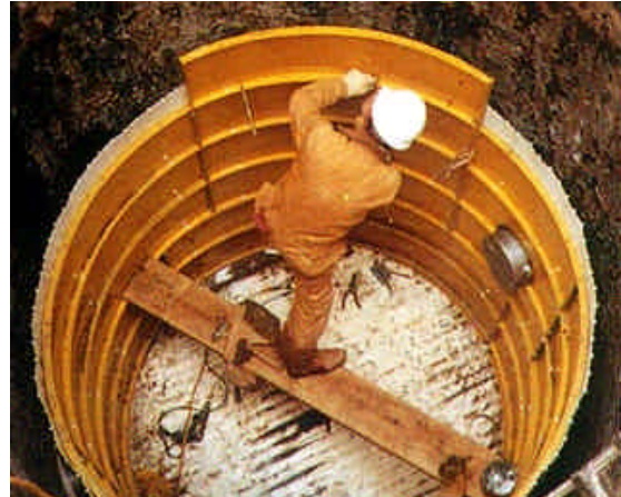
Abbildung 53: Einbringen von vorgefertigten PVC-Elementen in einen Schacht
