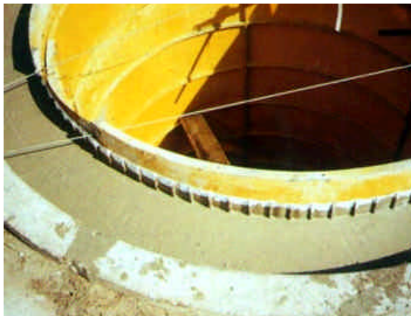
Abbildung 54: Auskleidung mit integriertem Verankerungssystem (PEHD)
