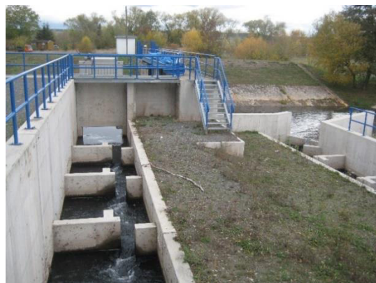
Abbildung 28: Fischaufstiegsanlage in der Nebenhelme bei Görsbach (Quelle: TLUBN)
