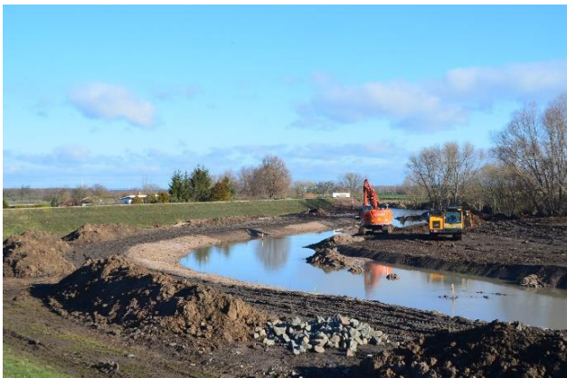
Abbildung 35: Naturnahe Umgestaltung der Gera bei Walschleben im Bau (Quelle: I. Andraczek)
