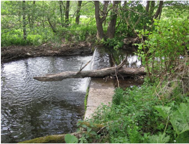
Abbildung 26: Sohlschwelle (Quelle: TLUBN)
