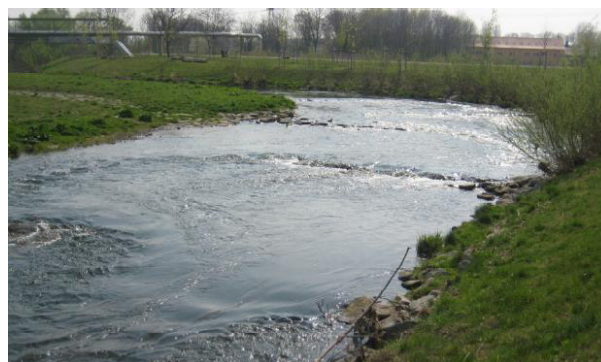
Abbildung 32: Neue Flussschlinge der Gera (Quelle: TLUBN)
