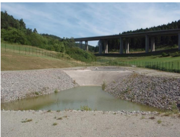
Abbildung 20: Regenrückhaltebecken an der A 71 zwischen Ellingshausen und Rohr (Quelle: Hegeholz, Wolfgang–TLUBN)
