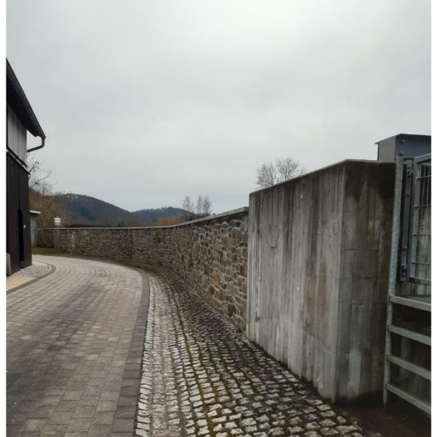
Abbildung 50: Deichbauwerk mit Deichverteidigungsweg in Wünschendorf (links); neu errichtete Hochwasserschutzmauer „Am Mühlgraben“ in Wünschendorf (rechts) (Quelle: TLUBN)
