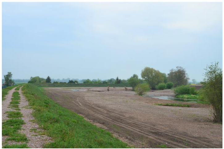
Abbildung 27: Umgestalteter Bereich der nördlichen Gera bei Walsleben (links) (gelbe Linie: Rückbau des Altdeiches); Entstandener Raum für den Hochwasserrückhalt und für eine naturnahe Gewässerentwicklung und Auenrenaturierung (rechts) (Quelle: Andraczek, Ines)
