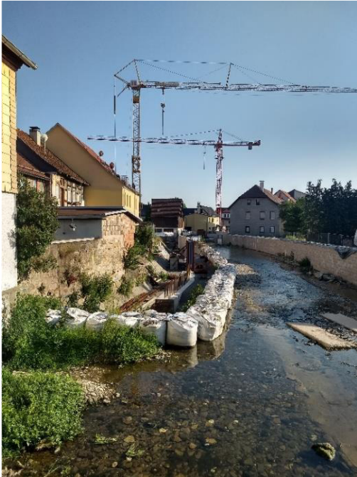
Abbildung 49: Hochwasserschutzprojekt Eisfeld (Quelle: Goerigk/DWA-LV S/T)
