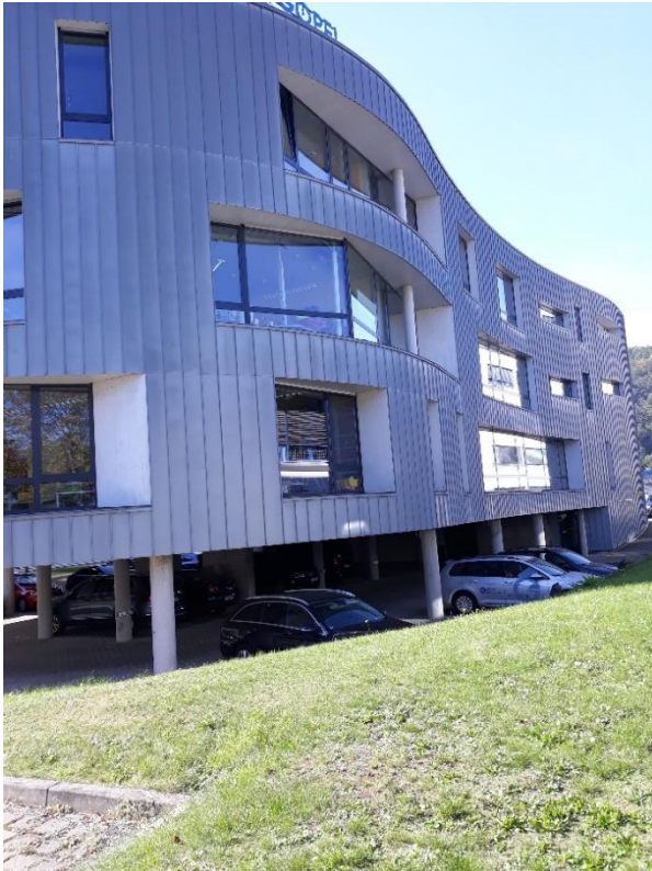
Abbildung 15: Aufgeständerte Bauweise in Jena-Göschwitz in der Nähe der Saale (Quelle: ThLG)
