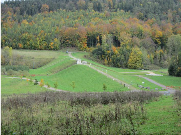
Abbildung 37: Absperrbauwerk Hochwasserrückhaltebecken Angelroda (Quelle: TLVwA, STAA)
