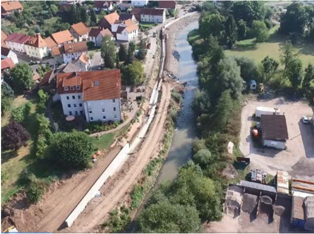
Abbildung 51: Errichtung der Hochwasserschutzmauer Stedtfeld (Quelle: TLUBN)
