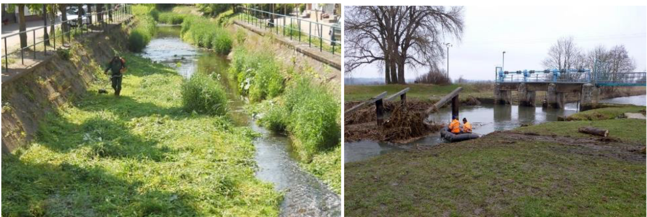
Abbildung 29: Mähen (links) und Beseitigung der Abflusshindernisse (rechts) im Rahmen der Gewässerunterhaltung (Quelle: Eichholz, Norbert)
