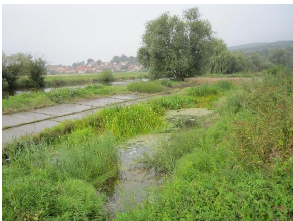
Abbildung 45: Verlandungen im Bereich des Streichwehres vor der Baumaßnahme (Quelle: TLUBN)
