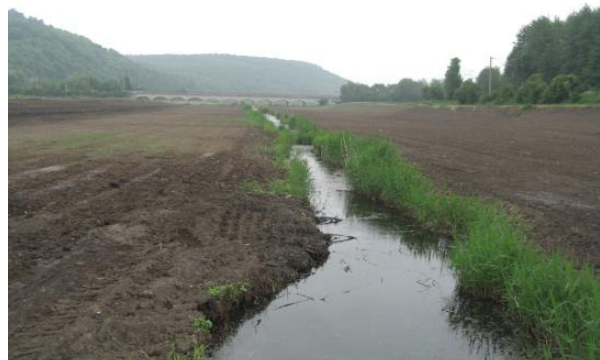
Abbildung 46: Beräumte Flutmulde unmittelbar nach der Baumaßnahme (Quelle: TLUBN)
