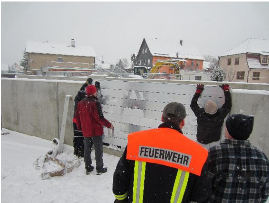
Abbildung 55: Dammbalkenverschlüsse Hochwasserschutz in Harras (Quelle: TLUBN)
