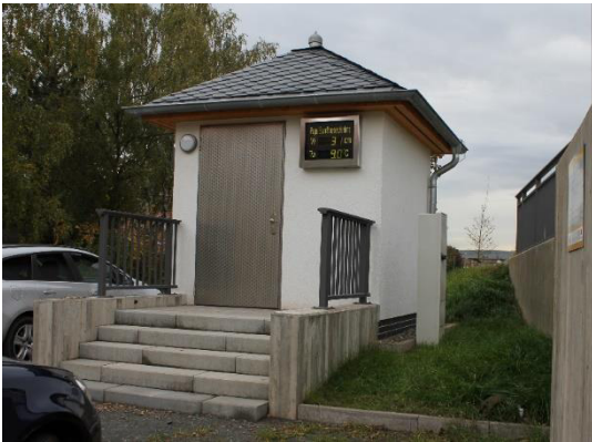
Abbildung 42: Hochwassermeldepegel an der Helme in Sundhausen (Quelle: ThLG)
