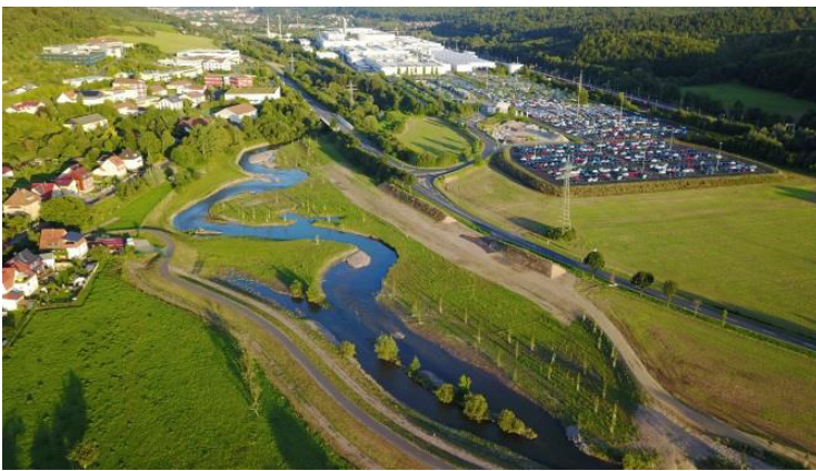
Abbildung 33: Verlegung der Hörsel bei Eisenach (Quelle: Rauschenberg, Marcel; Aufnahme vom 01.09.2017)
