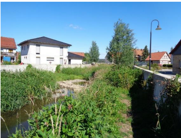
Abbildung 48: Hochwasserschutzanlage Harras (Quelle: TLUBN)
