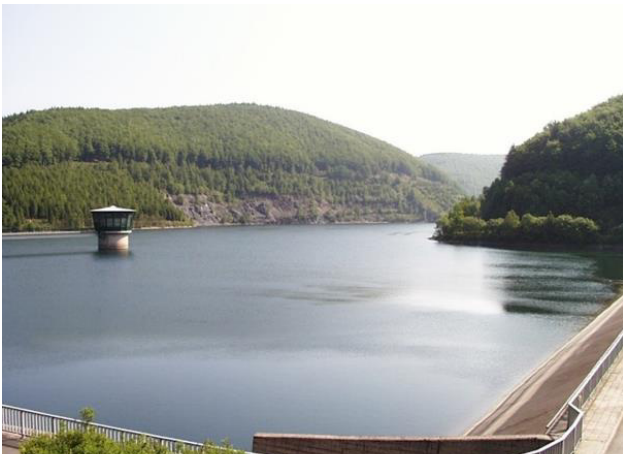
Abbildung 38: Talsperre Schönbrunn-Blick – auf den Entnahmeturm und die rechte Seite des Absperrbauwerks (Quelle: TFW)
