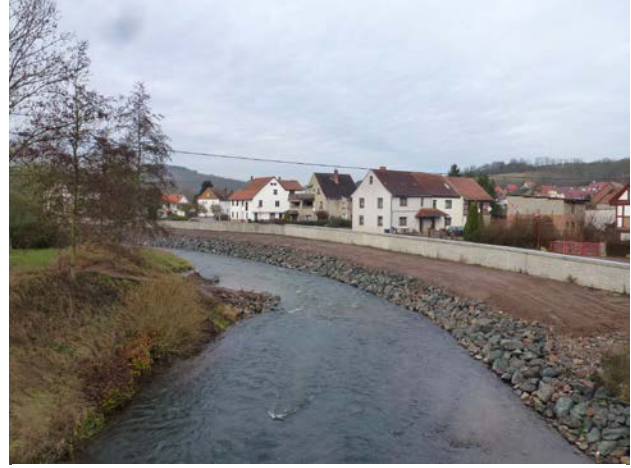
Abbildung 52: Fertigstellung der Hochwasserschutzmauer Stedtfeld (Quelle: TLUBN)
