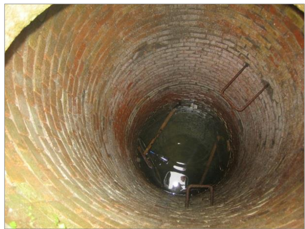
Abbildung 50: Blick in einen Wasserbrunnen (Quelle: ThLG)
