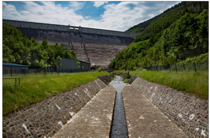
Abbildung 60: Unterwasserabgabe der Trinkwasserstalsperre Leibis/Lichte (Quelle: TFW)
