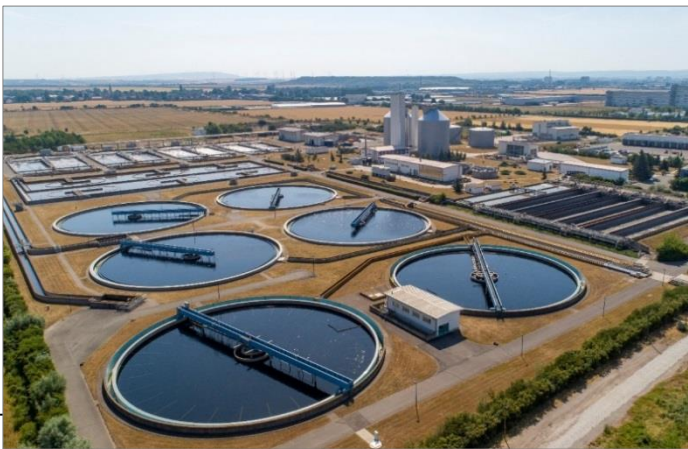
Abbildung 11: Luftbild der Kläranlage Kühnhausen (Quelle: Erfurter Entwässerungsbetrieb)
