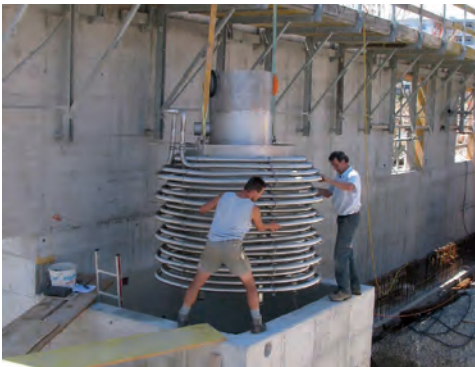
Abb. 25 Bau einer Abwasserwärmerückgewinnung in gebäudenahen Schächten (FEKA2009).
