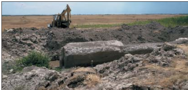
Abb. 3: 2002. Der Abriss des Schiffahrtskanals. Aus dem durchschnittlich von einem 5 m hohen Damm umgebenen, 5 m breiten Kanal mussten bei der Aufschüttung mehrere riesige Betonobjekte entfernt werden. (Foto: Sz. Göri)
