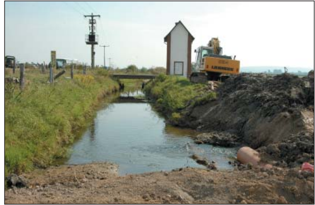
Abb. 7: Sanierungsmaßnahmen am Grabensystem stellen künftig die Regulierung des Wasserstandes im Ried sicher.
