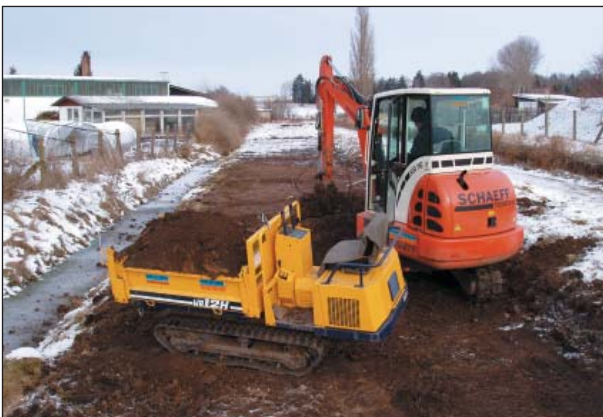
Abb. 5: Entfernung der Ruderalvegetation und der Aufschüttungen im Februar 2005
