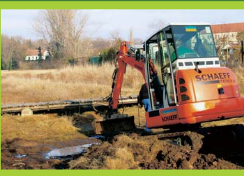
Biotopentwicklungsarbeiten am Arterner Solgraben, die mit LIFE-Mitteln finanziert werden.
